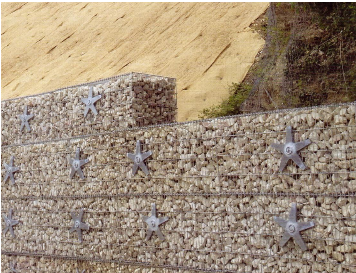
GABIONI UČVRŠĆENI ZA POKOS SISTEMOM SIDARA
